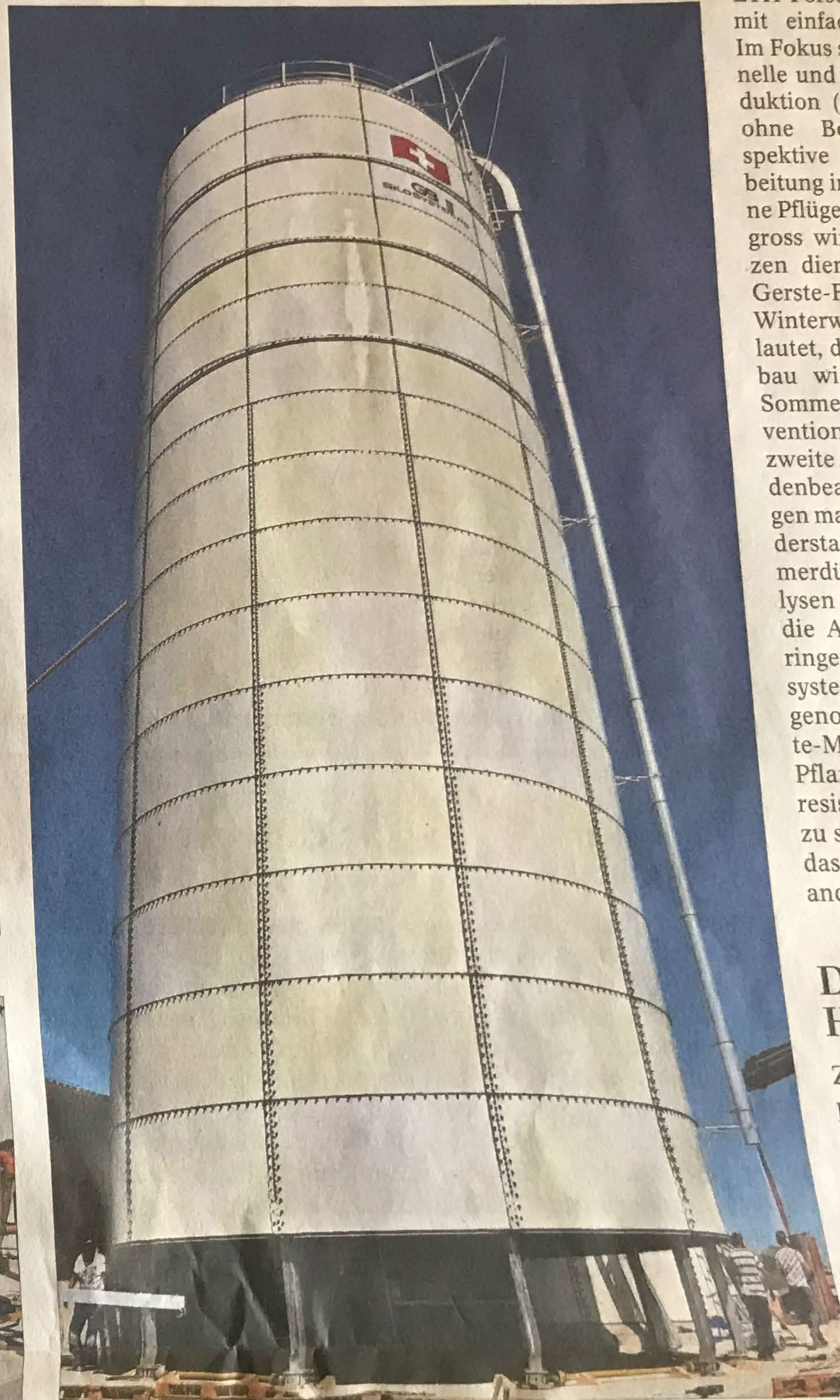
Das Silo wird bei der Montage hydraulisch hochgestemmt.
