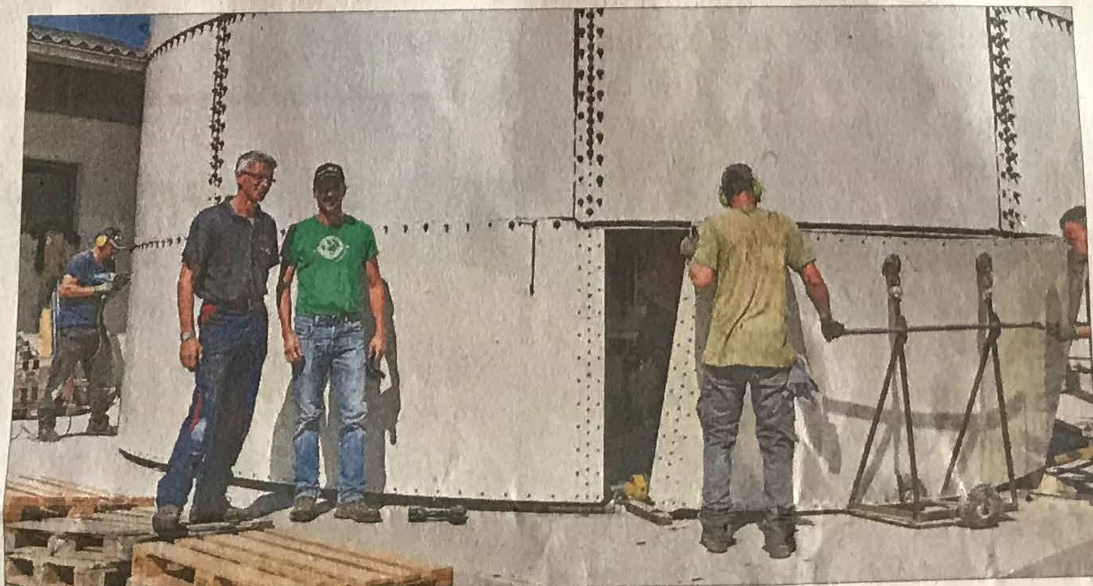
Die letzte glasbeschichtete Stahlplatte wird herangefahren.
